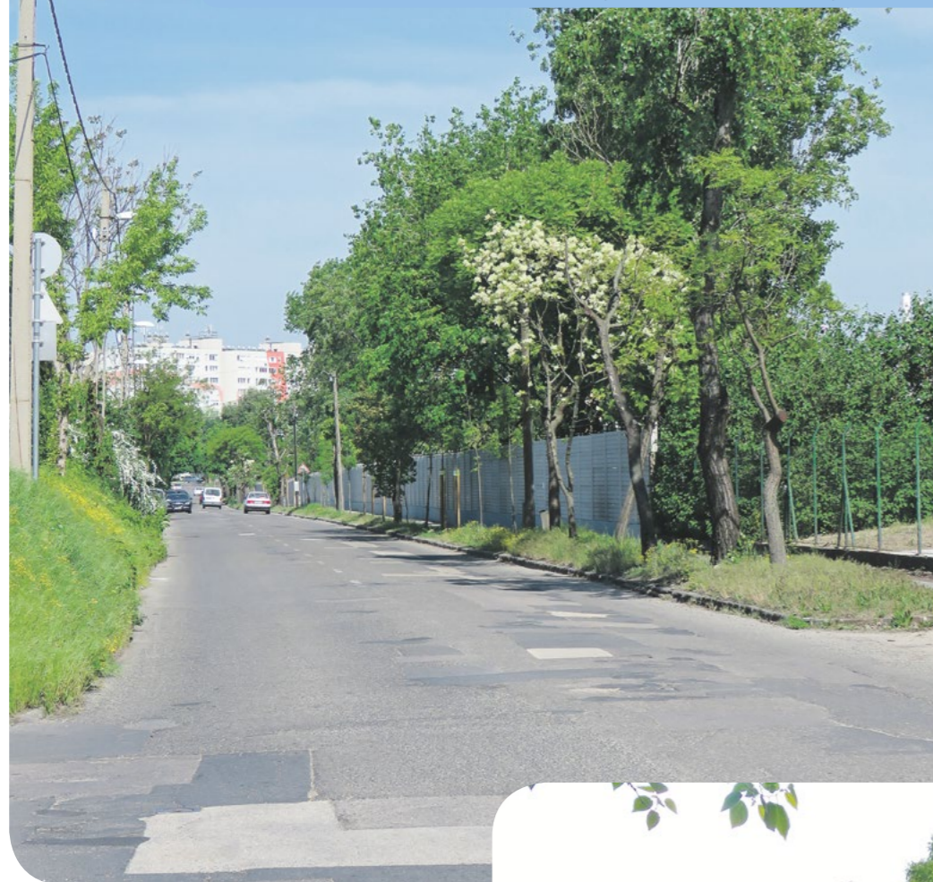
A Popietuszko utcában felbontják a részlegesen tönkrement teherbíró és aszfaltrétegeket, kétoldali szegélyeket
